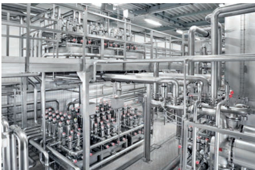
Les manifolds à deux niveaux automatiques avec leurs vannes à clapet double siège étanches au mélange DN125/100 permettent d'activer dix cuves sur sept lignes de remplissage.
