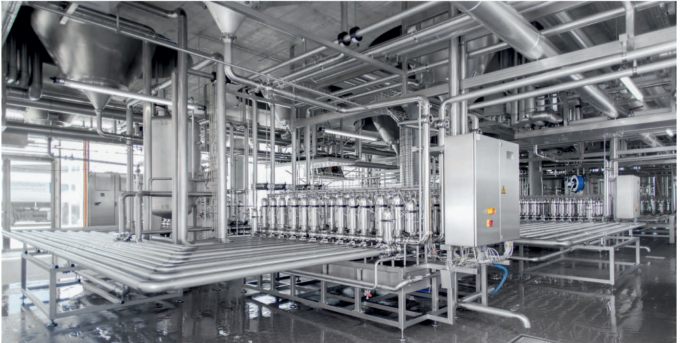
4.000 Meter Trägerrohr und 5.400 Meter Getränkeleitungsrohr (davon 900 Meter vorisoliert) für einen hochmodernen Gär- und Lagerkeller
